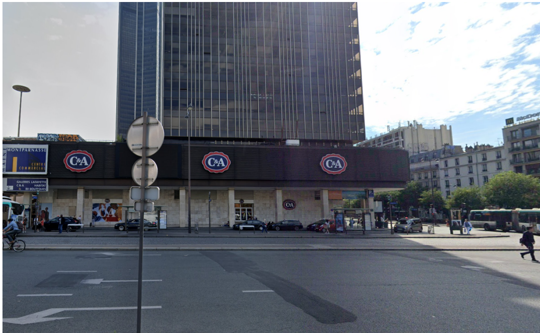
Figure 6 Place du 18 Juin 1940, source Google Streetview
